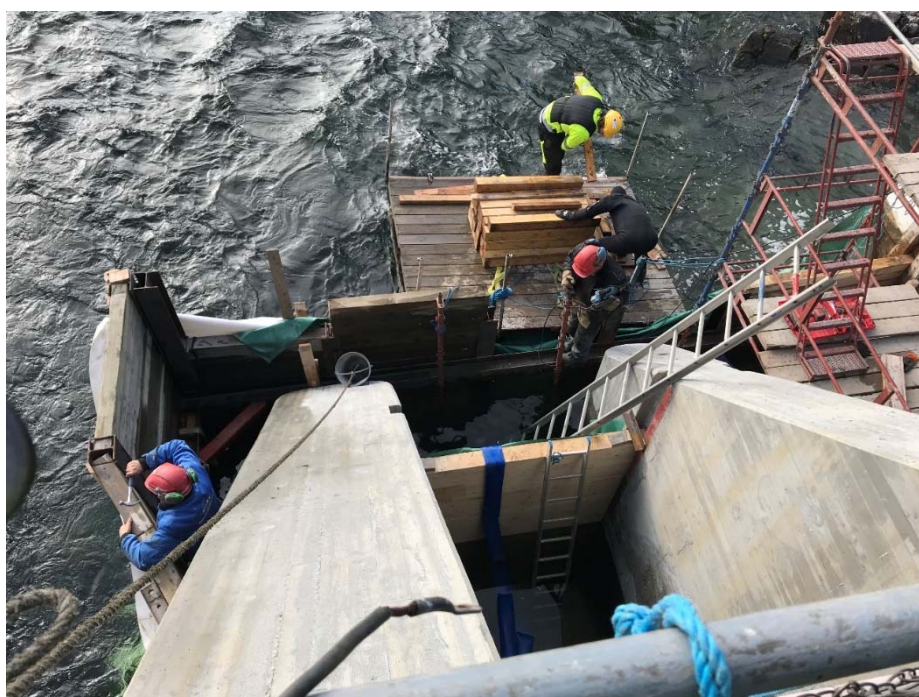
Slidrefjord, rehabilitering av bunnløp er ferdig og fangdammen fjernes. 11.oktober. Foto: Øyvind Eidsgård
