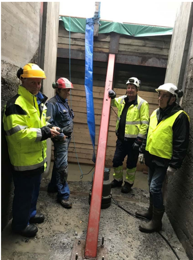
Slidrefjord, rehabilitering av bunnløpet. F.v. Gunnar Fagerås (FBR), Odd Bekkelien (Sanne- Hauglid), Ingvar Sletten (Eidsiva Vannkraft), Vidar Gullaug (Norconsult). Foto: Øyvind Eidsgård
